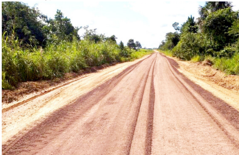
O serviço é executado nos 38 quilômetros da rodovia que interliga a BR-429 à RO-135
