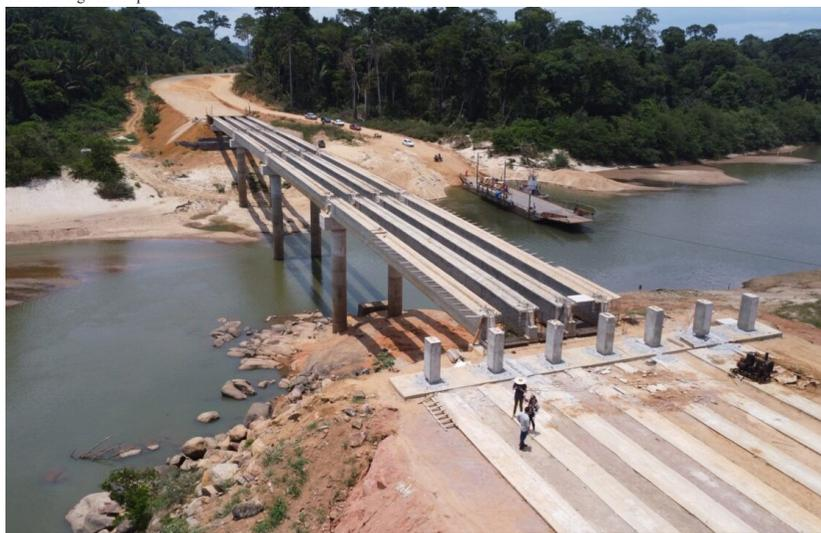
Ao todo, foram instaladas 16 vigas pré-moldadas, com 38 metros de comprimento e 45 toneladas cada uma
